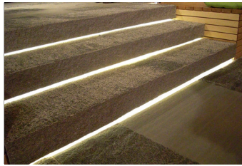
Treppenbeleuchtung mit LED-Linearleuchte
